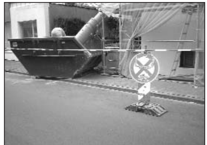
Oft unverhofft: Baustelle mit Halteverbot
